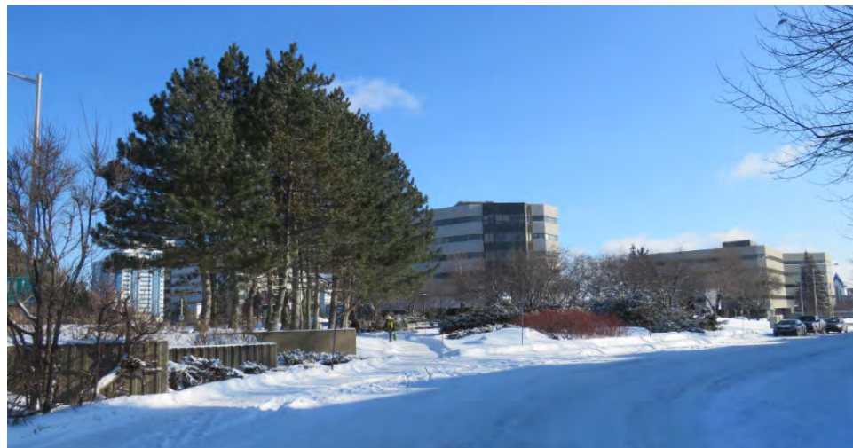
Côté ouest du parc. IMG_9006.jpg
