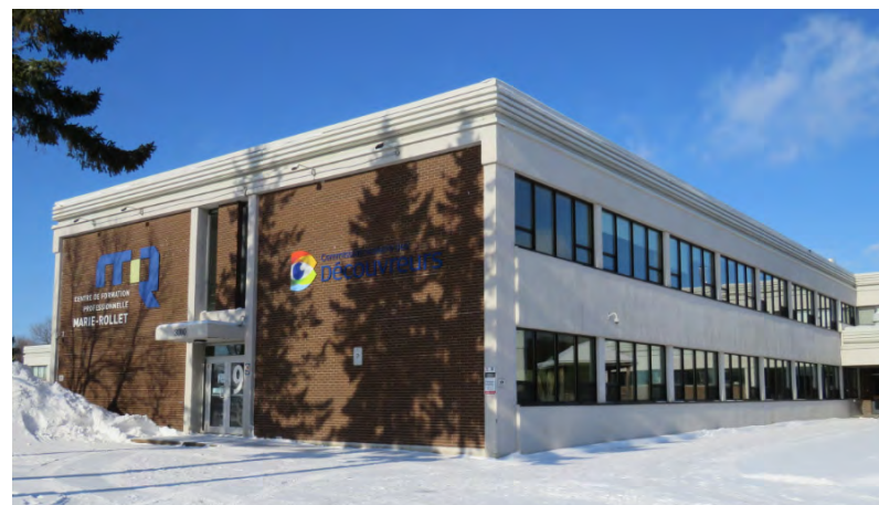
Aile sud – Entrée principale. IMG_8970.jpg
